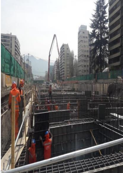
Armado de vigas travesaño y losas superiores de los módulos norte, central y sur
