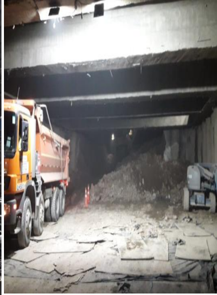
Cale desde Frentes de excavación Vitacura-Cerro Colorado, bajo Estructura E-14 (PSCO).
