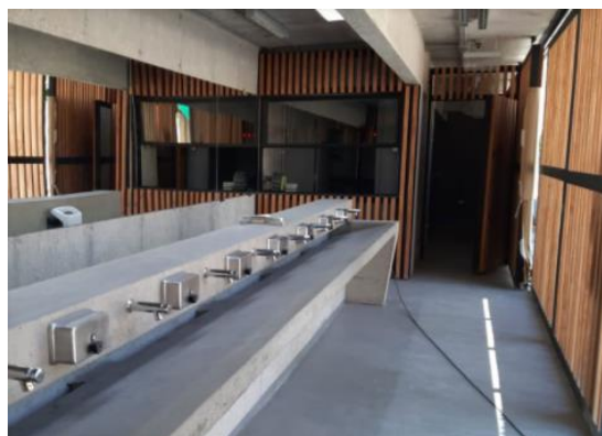
Imagen: Habilitación servicios sanitarios Parque Bicentenario
