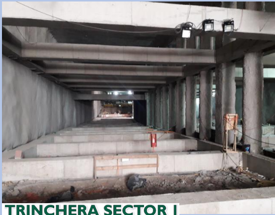
TRINCHERA SECTOR I
