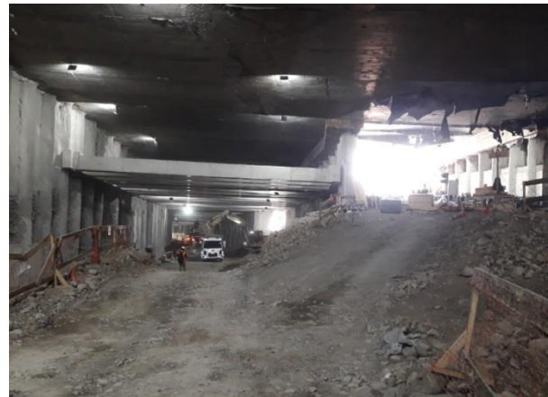
En el nivel intermedio con tránsito en dirección Sur-Norte (SN) se completa las losas a nivel -1, conectando los frentes de Puente Centenario-Vitacura y Riesco (vista salida Puente centenario).
