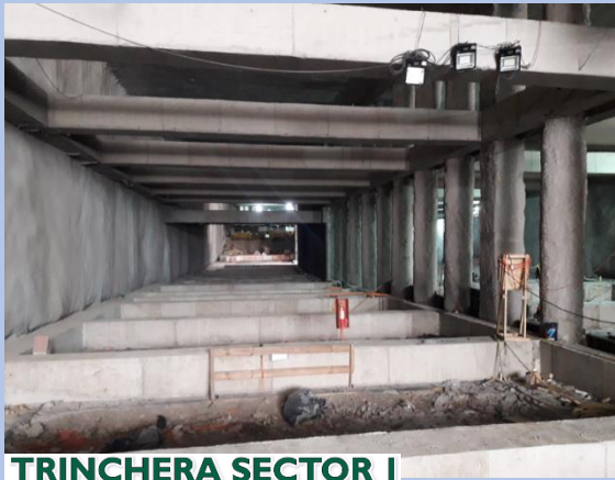
TRINCHERA SECTOR I
